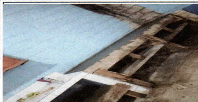
Foto 1: SUSTITUCION DE COCINA MEJORADA EN MAL ESTADO POR MESA DE CONCRETO.
