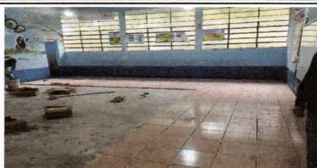
Foto 2: SUSTITUCION DE PISO DE CONCRETO POR PISO CERAMICO, EN AULAS Y DIRECCION
