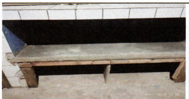
Foto 5: CAMBIO DE SOPORTES DE MADERA POR SOPORTES DE CONCRETO
